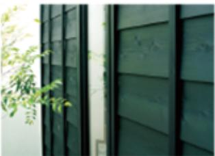
建物の雰囲気を作る黒い板塀は、防火構造上使用不可。下地にサイディングを貼った上で板塀で仕上げている。
